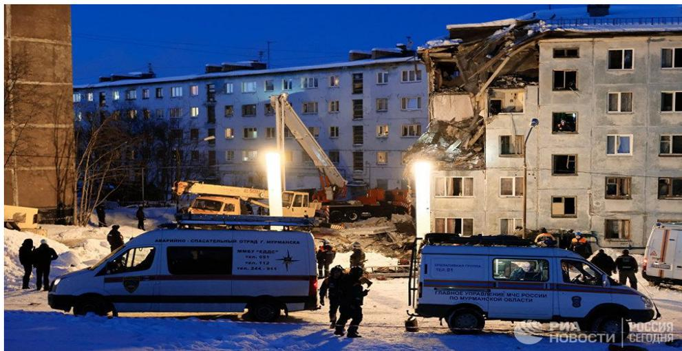
(Последствия произошедшего 20.03.2018 г. взрыва бытового газа в пятиэтажном жилом доме в Мурманске. В результате ЧП произошло обрушение кровли, перекрытий и фасадной стены со второго по пятый этажи угловой части дома. Один человек погиб, пять пострадали.)
