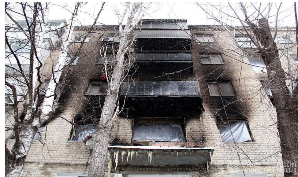
(Последствия произошедшего 04.05.2016 г. взрыва бытового газа в девятиэтажном многоквартирном доме в г. Балаково Саратовской области. В результате ЧП разрушены 20 квартир, погиб один человек.)
